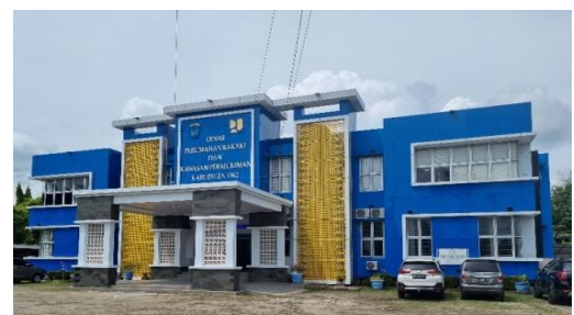
Gambar 2. Fasad Banunan Gedung DPRKP Kab.OKI . (Sumber Dinas PRKP Kab OKI, 2025)
