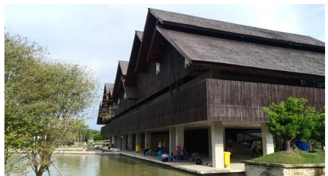
Gambar 5. Design bangunan yang dibiarkan terbuka sehingga mengurangi konsumsi listrik untuk lampu dan AC
