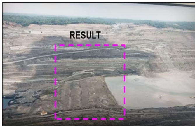
Gambar 12 Kondisi Sekat Setelah Selesai Dikerjakan
